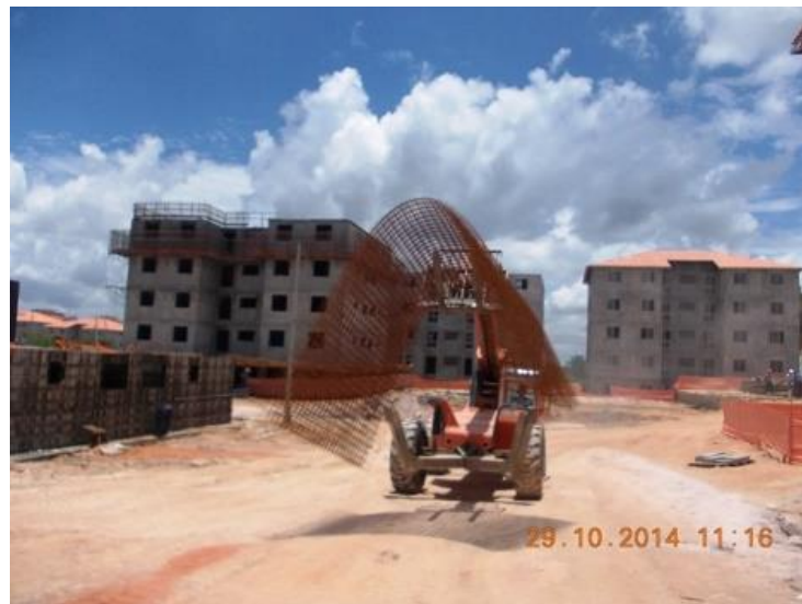
Figura 7 – Transporte de armadura na obra Fonte: Pesquisa direta
