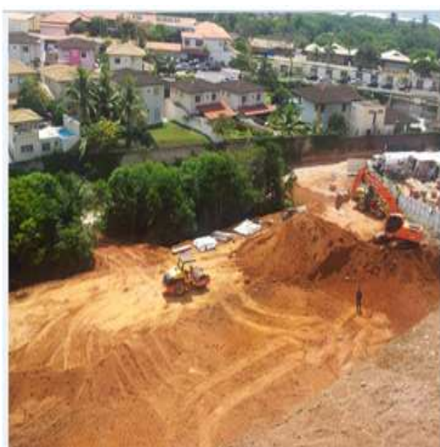
Figura 26 – Corte e limpeza do terreno. (Fonte própria)
