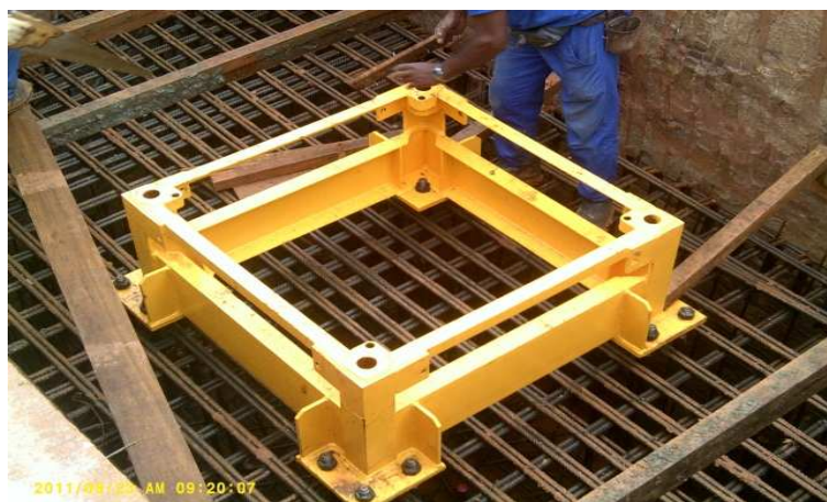
Figura 16 - Fundação da grua. (Fonte própria)
