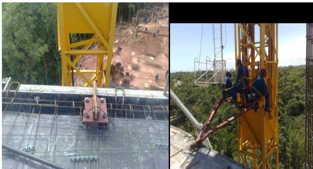
Figura 20 - Estrutura de ancoragem para travar a grua fixa na torre do prédio. (Fonte própria)
