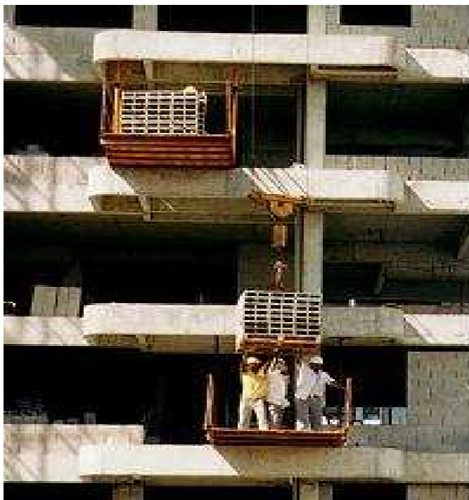
Figura 31 - Plataformas de recebimento de blocos nos pavimentos içados pela grua. Fonte: Ferreira (2011)
