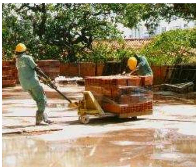
Figura 33 – Empilhadeira Hidráulica. Fonte: Ferreira (2011)
