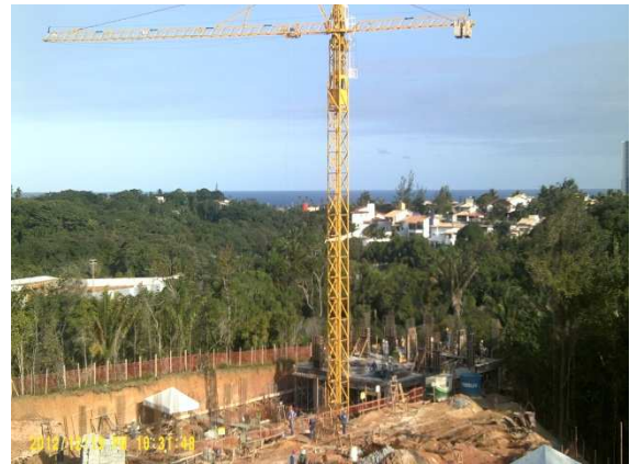
Figura 2: Grua fixa. (Fonte própria)
