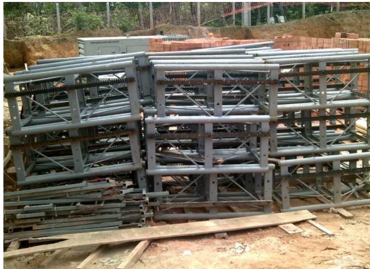
Figura 21 - Estoque de elementos do elevador cremalheira. (Fonte própria)
