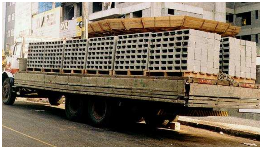
Figura 30 - Chegada de blocos palletizados no canteiro. Fonte: Ferreira (2011)
