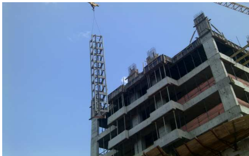
Figura 22 - Elementos sendo içados pela grua (Fonte própria)
