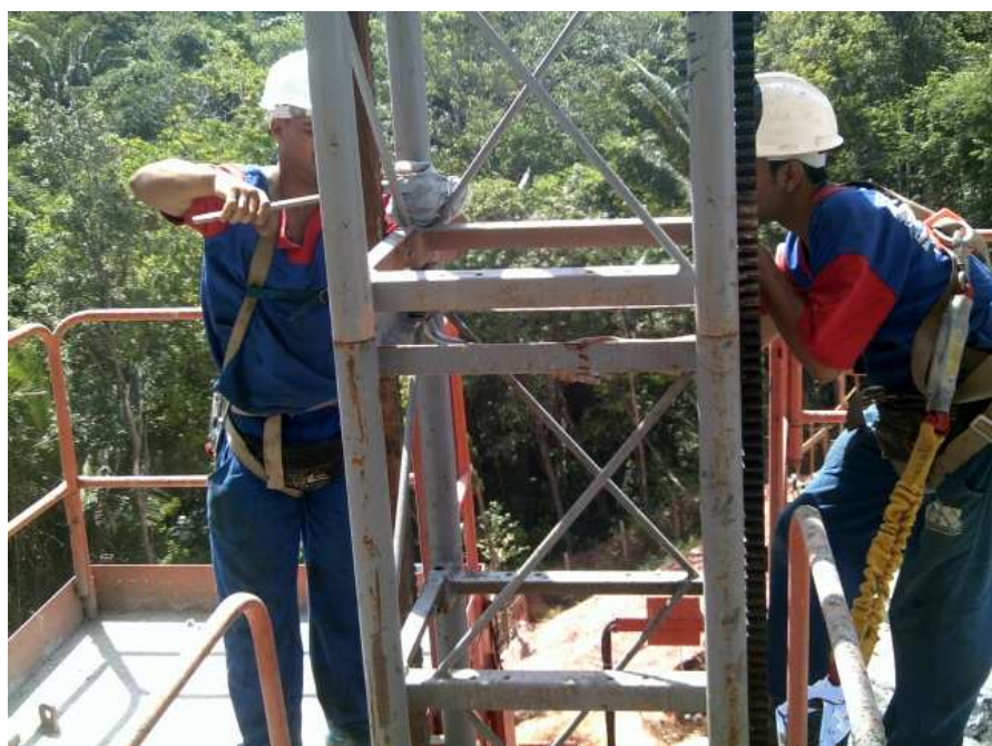
Figura 23 - fixação dos novos elementos. (Fonte própria)
