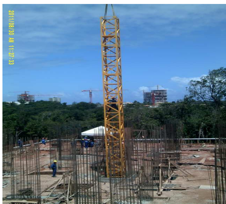
Figura 17 - Torre de uma grua. (Fonte própria)
