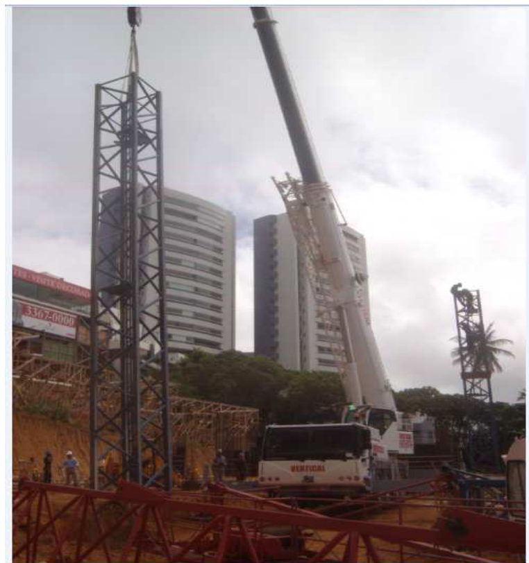
Figura 19 - Montagem da grua. (Fonte própria)
