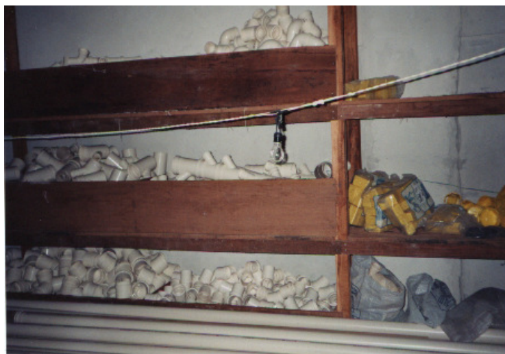
Foto 5: Materiais para instalação
