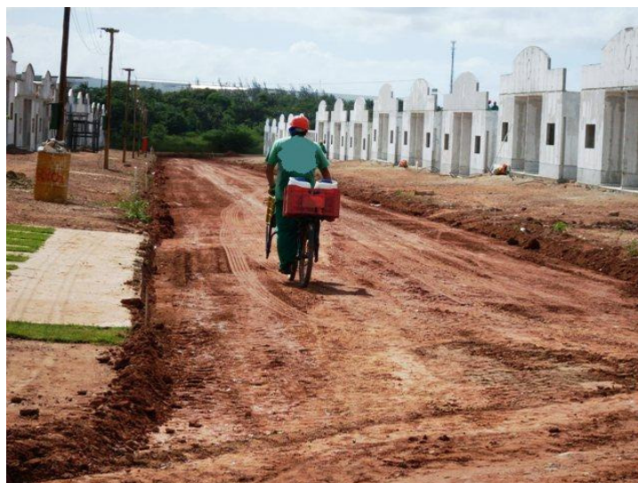
Figura 14 – Distribuição de água no canteiro Fonte própria
