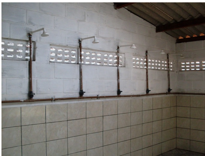
Figura 5 – Área de banho Fonte própria
