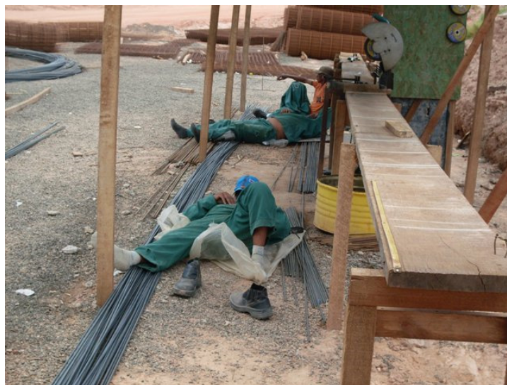
Figura 10 – Cochilo no canteiro de obras Fonte própria
