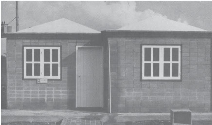
Figura 12 - Fotografia da unidade construída com cerâmica armada (LUGARPA)
