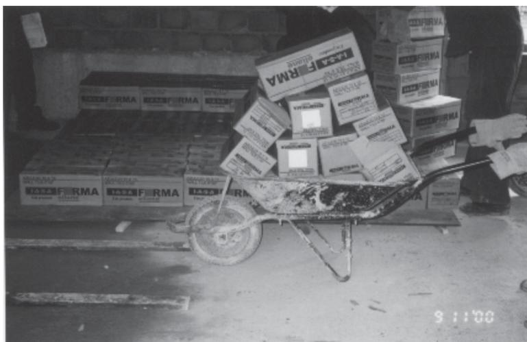
Figura 27 - Transporte inadequado de materiais na obra
